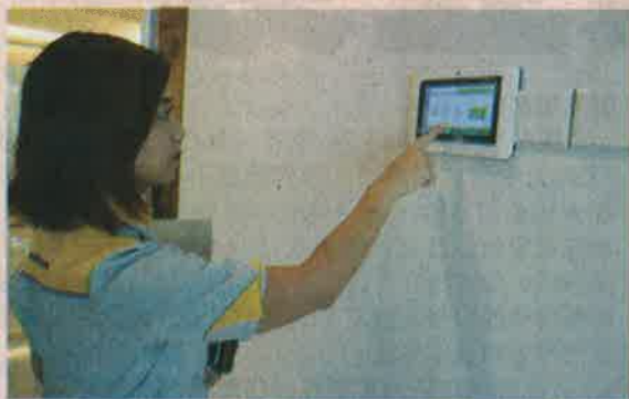
屋内装有智能家居系统，可遥控居家的冷气、灯光、与保安厅系统连系、更能呼叫升降梯；提供住户极度方便以及最具现代化的理想居家。
